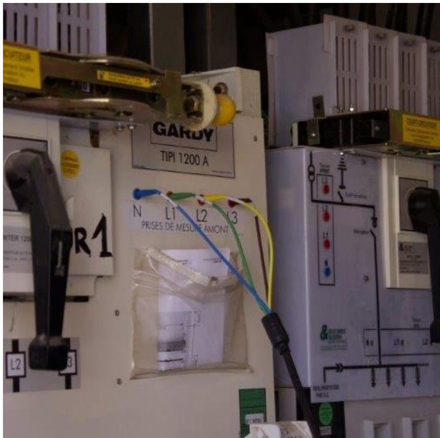
Exemple de raccordement à l'aide de fiches banane 4mm
