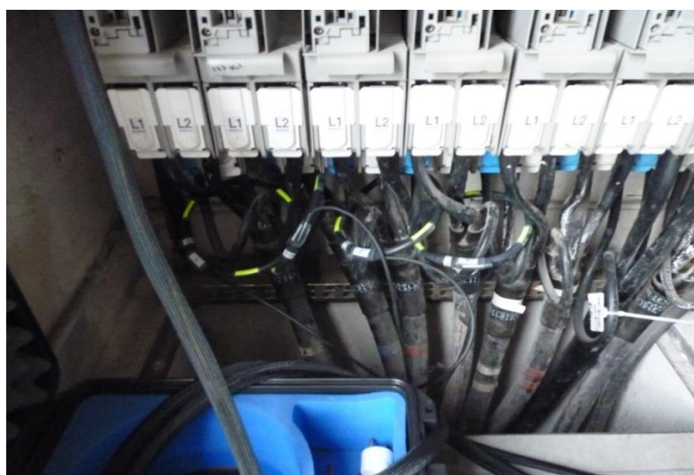
Mise en place d'un tore sur chaque départ du TIPI
