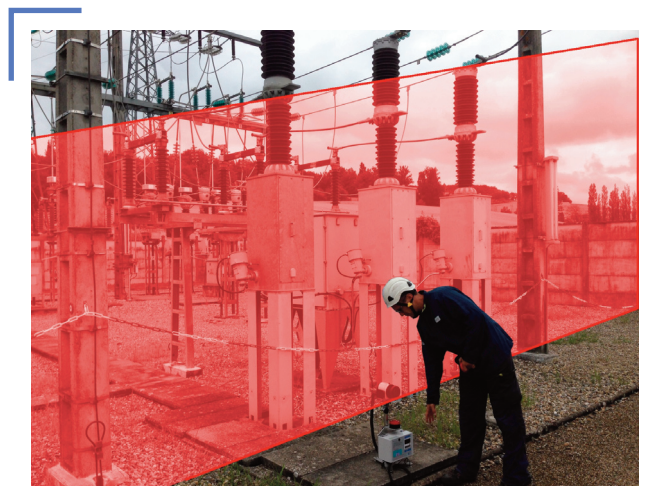
Travaux dans un poste source
