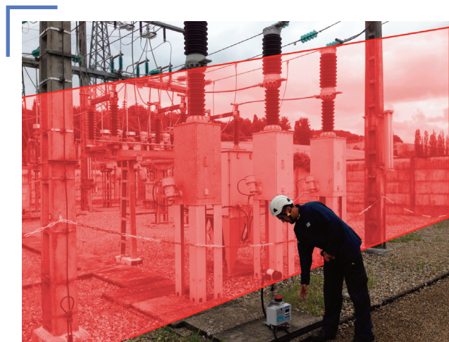
Travaux dans un poste source
