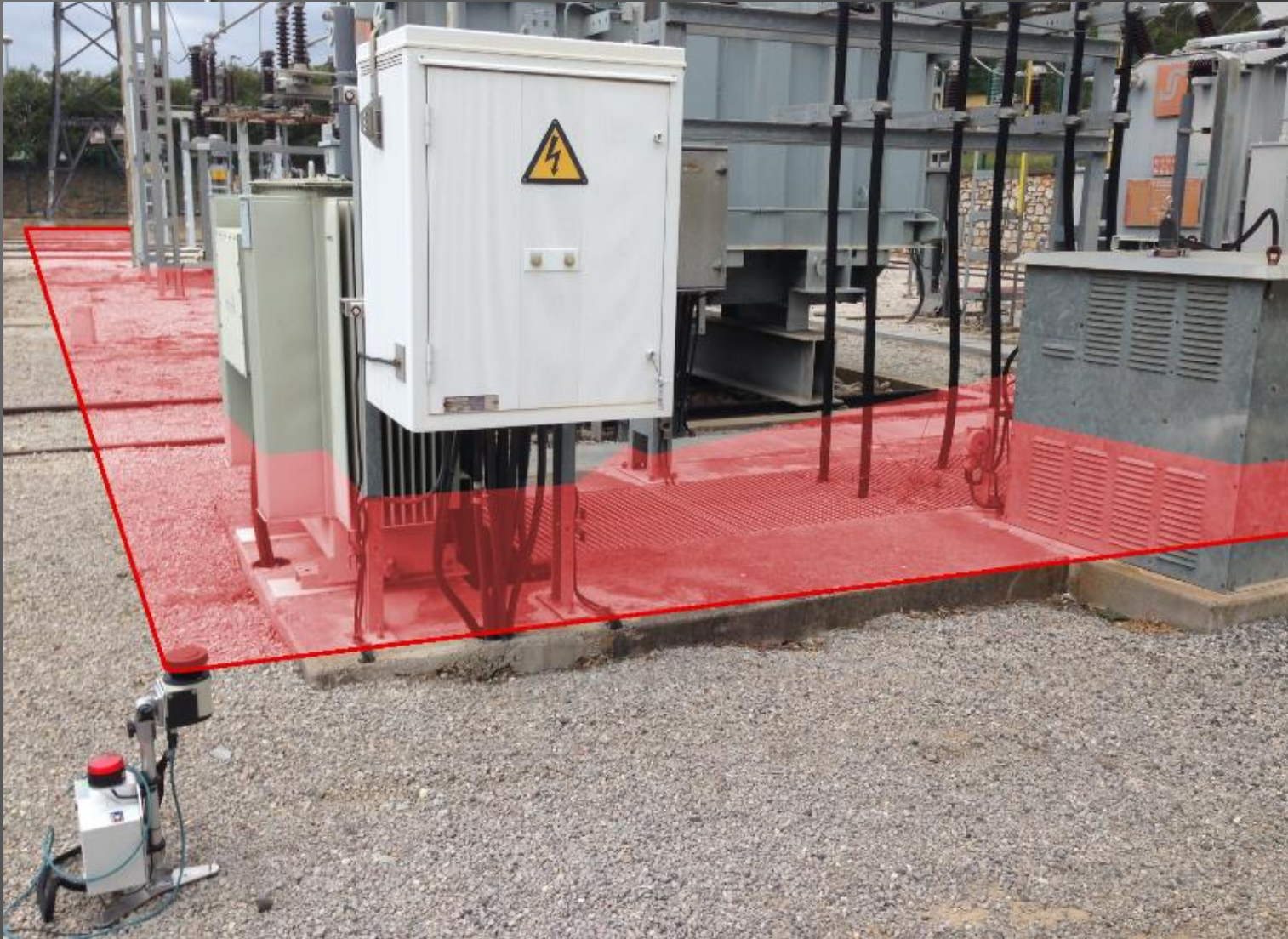
Exemple d'utilisation dans un poste ENEDIS
