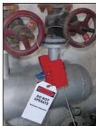
Composé de pince de sécurité et d'un câble en acier de 4 mm multifilament résistant et flexible, isolé avec un revêtement en plastique transparent (sans PVC). Identification par étiquette adhésive de sécurité avec les données du responsable de l'installation. S'utilise pour bloquer des robinets-vannes de différentes tailles et pour bloquer de multiples vannes.
