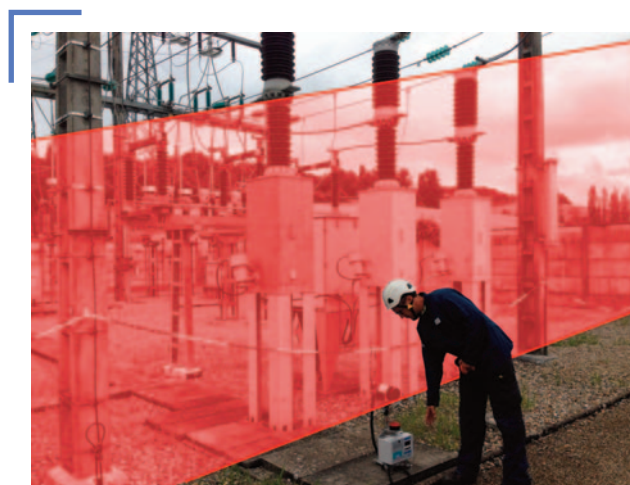
Travaux dans un poste source
