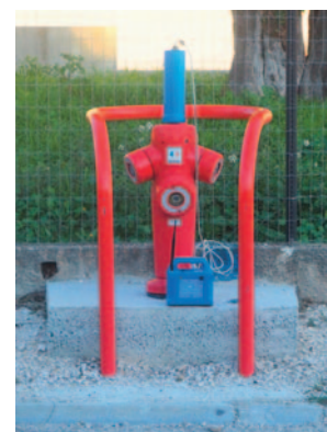
Injection avec percuteur sur borne incendie
