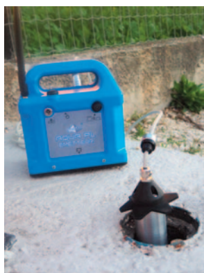
Injection avec percuteur sur bouche à clé
