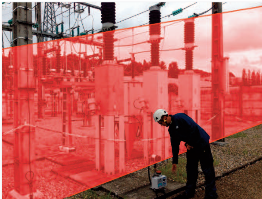
Opérations de maintenance dans un poste de Haute Tension
